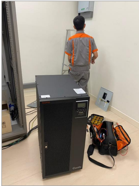
ภาพที่ ๑๖ : การติดตั้งเครื่องสำรองไฟฟ้าและตู้แบตเตอรี่
