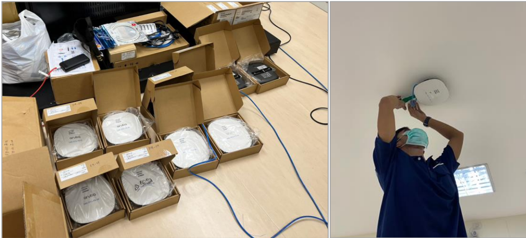
ภาพที่ ๑๙ : การติดตั้งอุปกรณ์กระจายสัญญาณแบบไร้สาย (Access Point)
