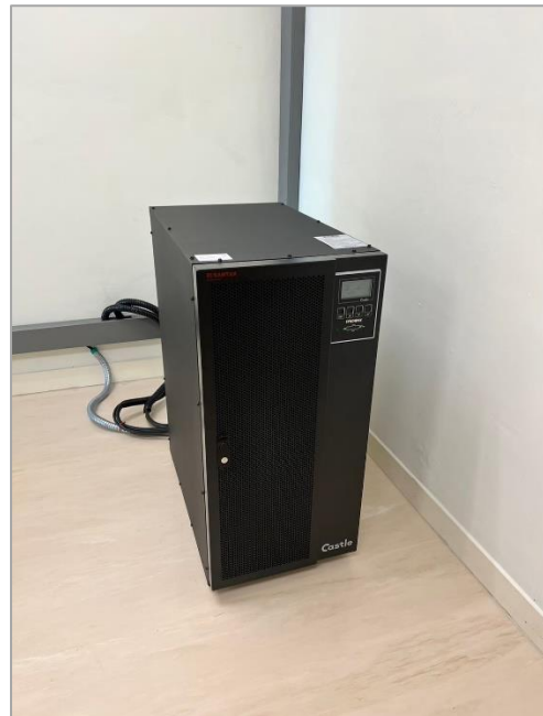
ภาพที่ ๑๗ : การติดตั้งเครื่องสำรองไฟฟ้าและตู้แบตเตอรี่
