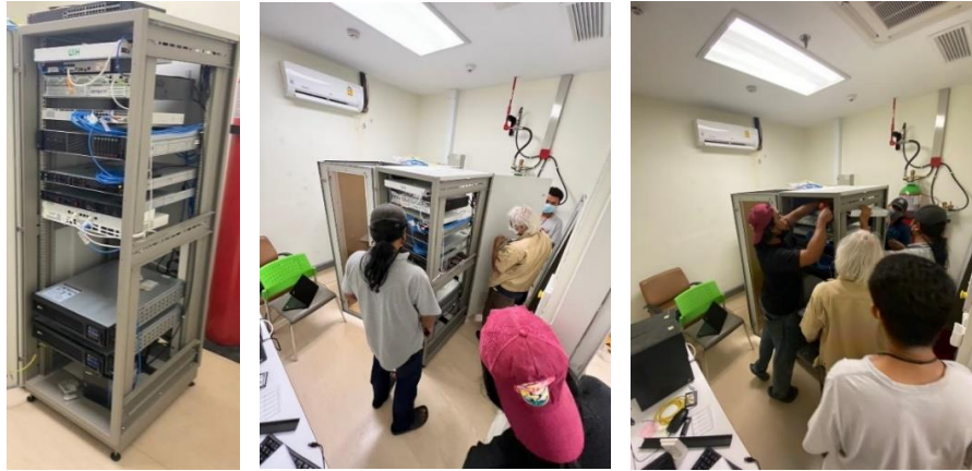
ภาพที่ ๘ : ปรับปรุงเคลื่อนย้ายอุปกรณ์ห้อง Server
