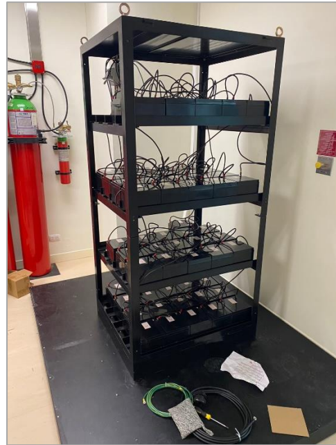
ภาพที่ ๑๖ : การติดตั้งเครื่องสำรองไฟฟ้าและตู้แบตเตอรี่
