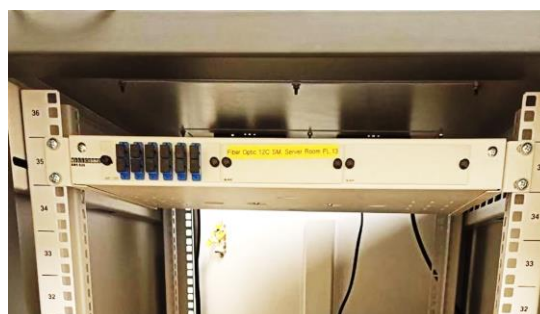
ภาพที่ ๑๐ : แผงกระจาย Fiber Optic ห้อง Server ชั้น ๑๒ และชั้น ๑๓
