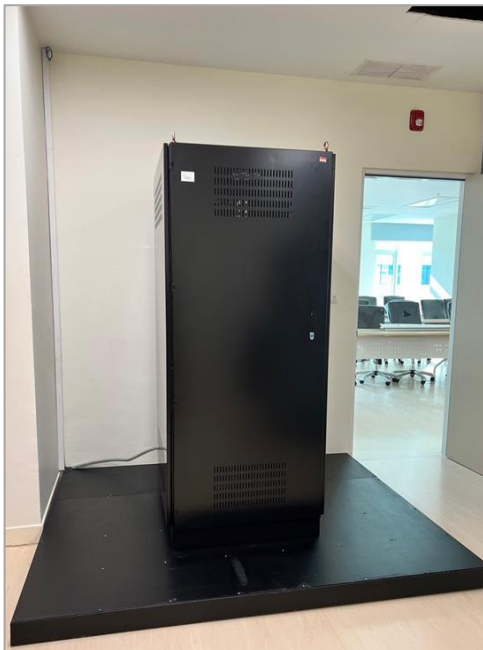
ภาพที่ ๑๗ : การติดตั้งเครื่องสำรองไฟฟ้าและตู้แบตเตอรี่
