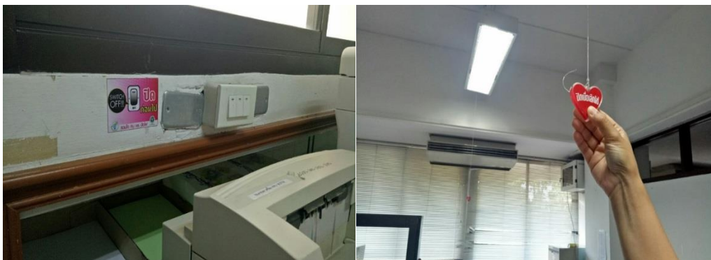
ติดป้ายเตือนเปิด-ปิดอุปกรณ์ไฟฟ้า
