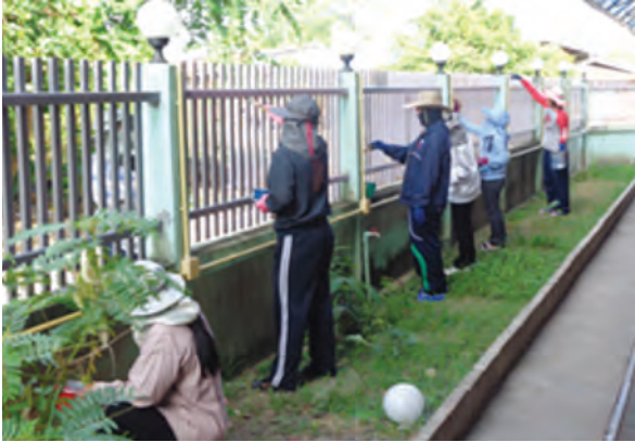
ภาพที่ 7-4 เปลี่ยนสีทาสีอาคารเป็นสีปลอดสารตะกั่ว
