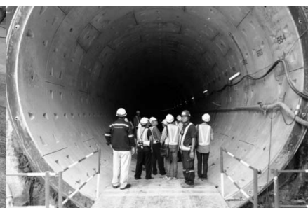
การก่อสร้างอุโมงค์รถไฟฟ้าใต้ดิน
