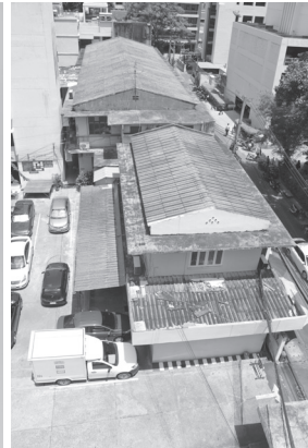
อาคารให้บริการตรวจโรคผิวหนัง ของโรงพยาบาลบางรัก
