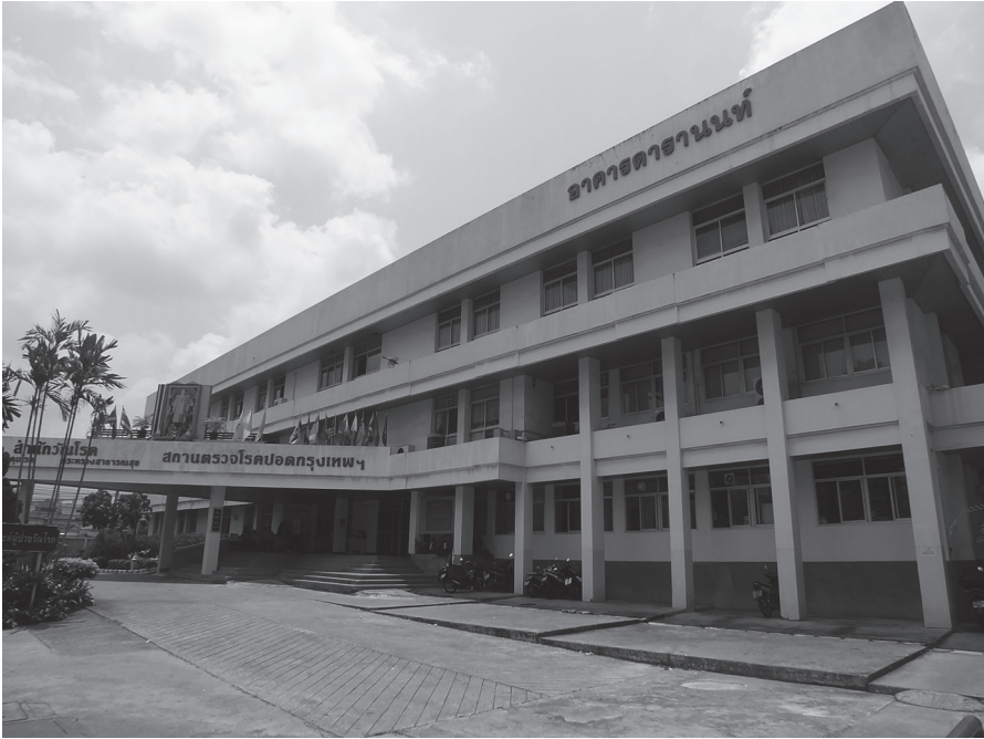
อาคารสถานตรวจโรคปอดกรุงเทพ เป็นที่ตั้งของสำนักวัณโรค
