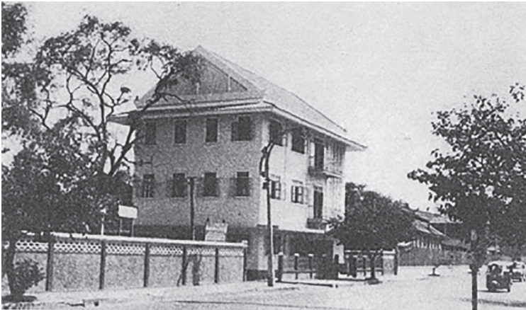
ภาพเก่าของอาคารบำบัดในสมัยก่อน
