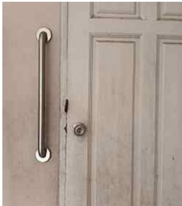
ติดตั้งราวจับ ปรับสิ่งแวดล้อมบ้านให้ปลอดภัย
