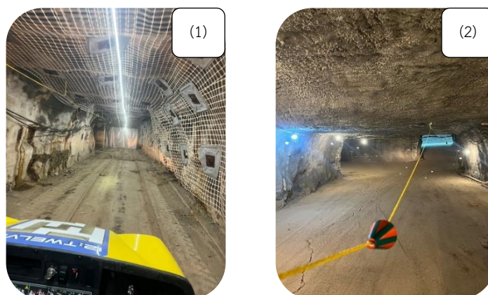
ภาพที่ 1 (1) ตาข่ายชิงบริเวณที่อาจจะมีการพังหรือทะลายลงมาของหิน (2) เชือก lifeline และ chamber รูปกรวย
